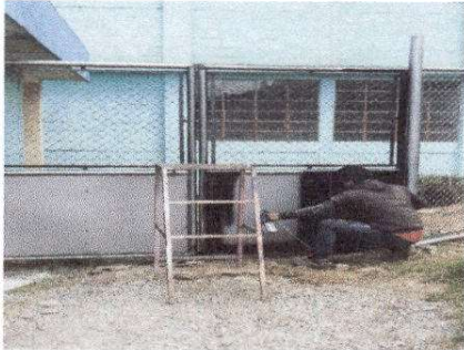
Foto1: Fabricación e instalación de portón de metal de ingreso
