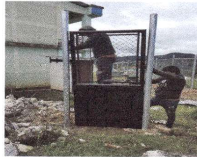
Foto 2: Fabricación e instalación de portón de metal de ingreso
