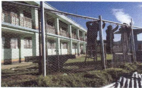
Foto 3: Reparación de tubo hg y maya galvanizada
