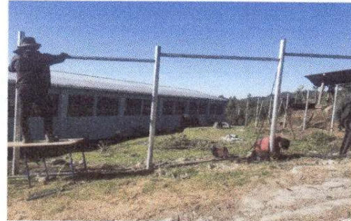
Foto 4: Reparación de tubo hg y maya galvanizada.
